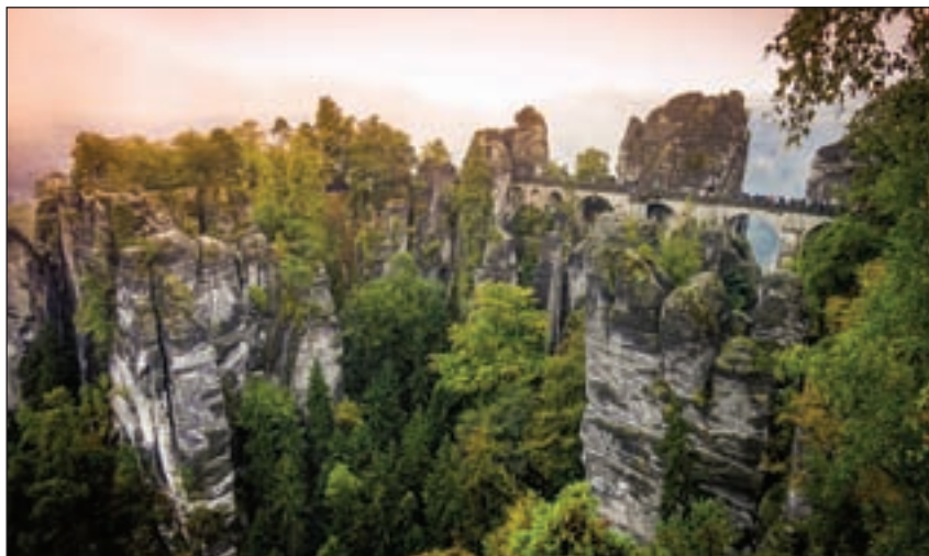
Dominanta Saského Švýcarska, unikátní most Basteibrücke, se tyčí do výše 194 metrů nad řekou Labe.
