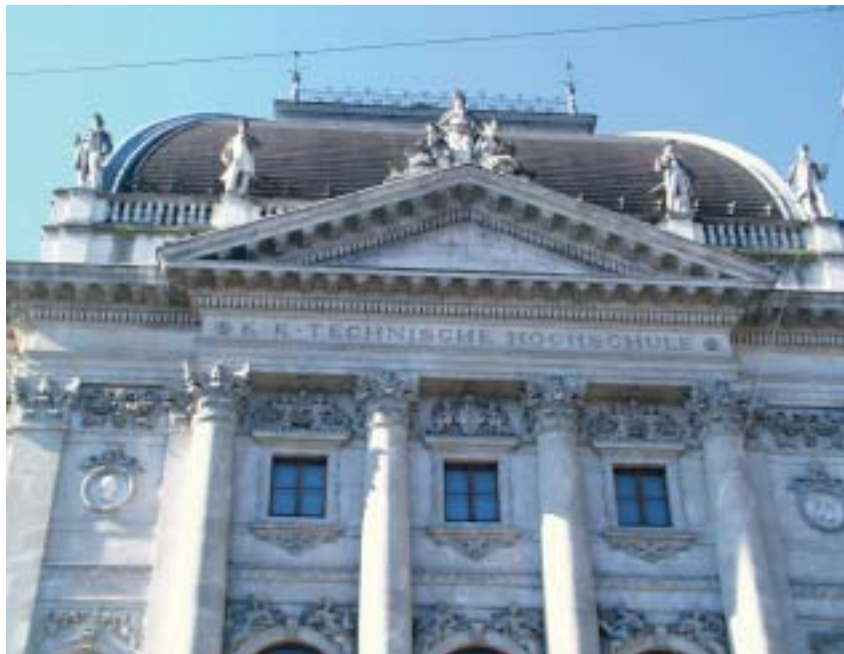
Hlavní budova Technické univerzity ve Štýrském Hradci
