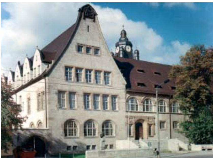
Pohled na hlavní budovu Universität Jena
