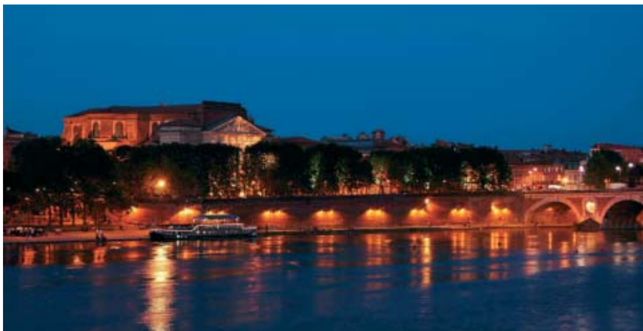
Pohled na budovu Institutu humanitních a sociálních věd univerzity v Toulouse
