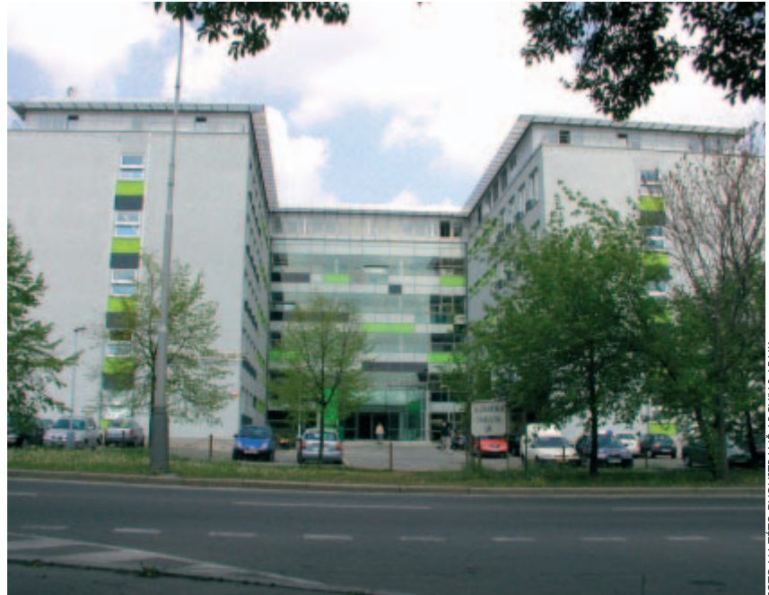
Budova 3. LF UK
