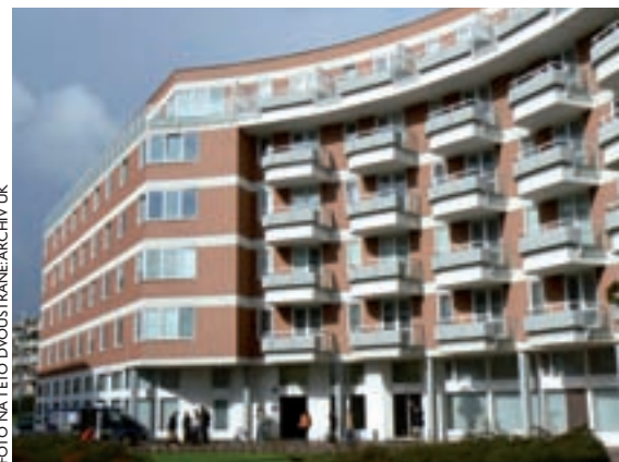
Budova v Jinonicích slouží třem fakultám Univerzity Karlovy – FHS, FSV a FF.
