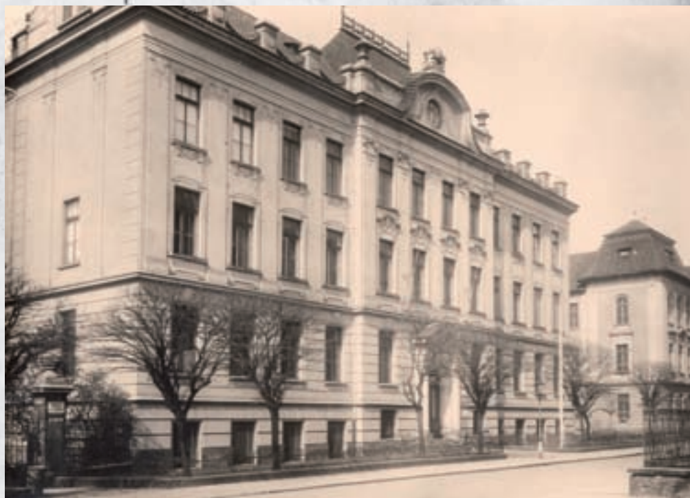
V roce 1910 byla vedle fyzikálního ústavu dostavěna i budova matematického ústavu, kde dnes sídlí děkanát MFF UK.
