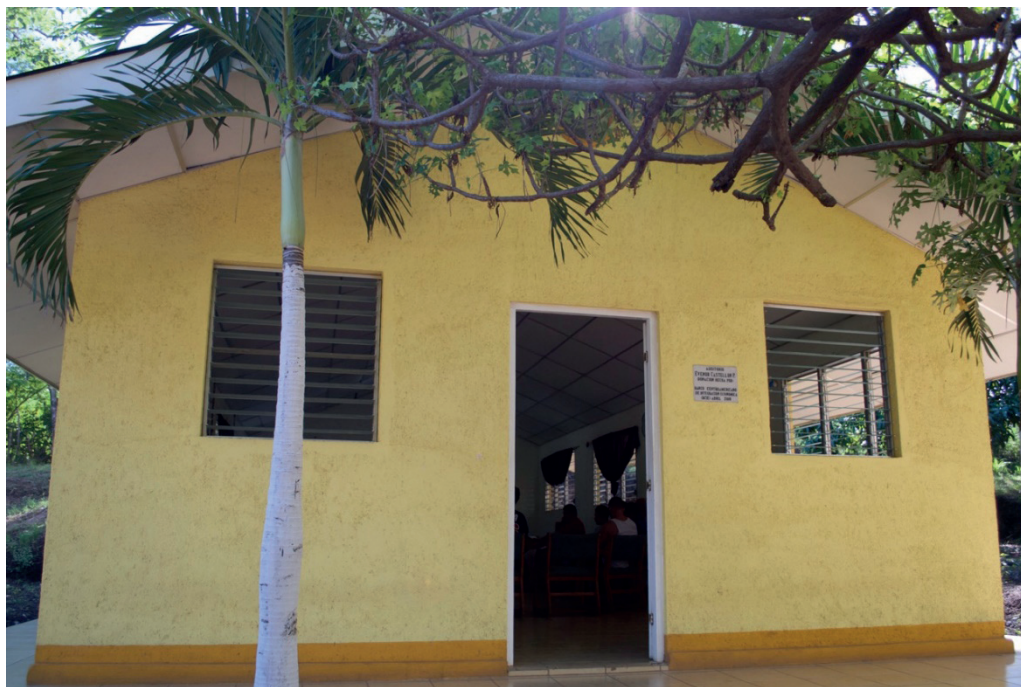
Obr. 21 CARA – posluchárna (zdroj: vlastní zpracování).
