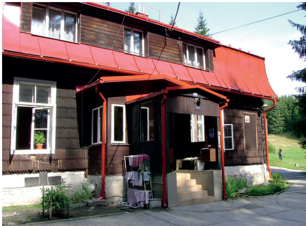
Obr. 6 Hlavní budova TK Renarkon (zdroj: archiv autora).
