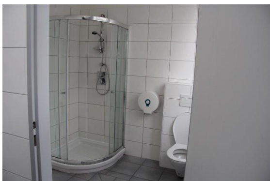
Zrekonstruovaná sociální zařízení v bloku C
